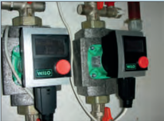
Bild Hochenergieeffizienz-Pumpen Wilo-Stratos Pico
