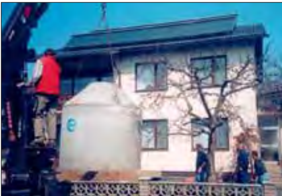
Bild: Versetzen der GEP-Regenwasserzisterne im Vorgarten von Ökohaus-Althaus
