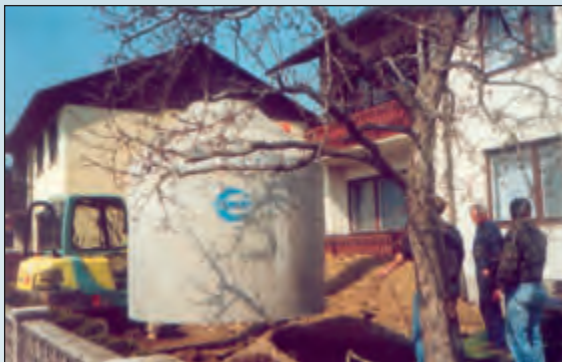
Bild Versetzen der GEP-Regenwasserzisterne im Vorgarten von Ökohaus-Althaus
