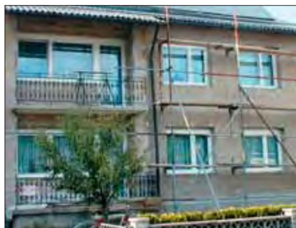
Wärmegeämmte Fassade von ÖkoHaus-Althaus mit Tektalan E-21
