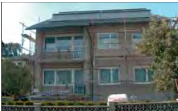
Wärmegeämmte Fassade von Ökohaushaus mit Tektalan E-21
