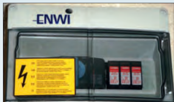
Bild Ökohaus-Althaus Generatoranschlusskasten von EnWi-Etec
