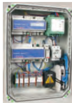
Bild: Datenloggerschrank von EnWi-Etec GmbH, Wurmannsquick - Deutschland mit Datenlogger Powador proLOG von KACO new energy GmbH, Neckarsulm - Deutschland
