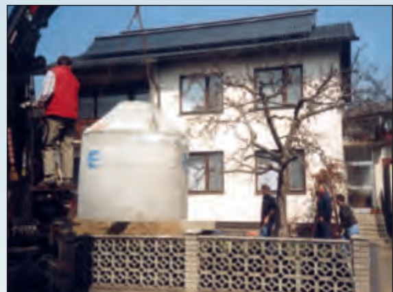
Bild Versetzen der GEP-Regenwasserzisterne im Vorgarten von Ökohaus-Althaus
