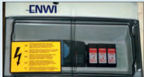
Bild Ökohaus-Althaus Generatoranschlusskasten von EnWi-Etec
