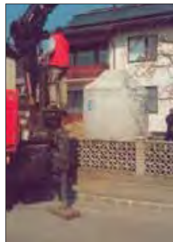
Bild: Versetzen der GEP-Regenwasserzisterne im Vorgarten von Ökohaush-Althaus
