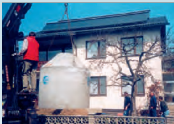
Bild Versetzen der GEP-Regenwasserzisterne im Vorgarten von Ökohaus-Althaus
