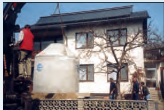
Bild: Versetzen der GEP-Regenwasserzisterne im Vorgarten von Ökohaushaus Althaus
