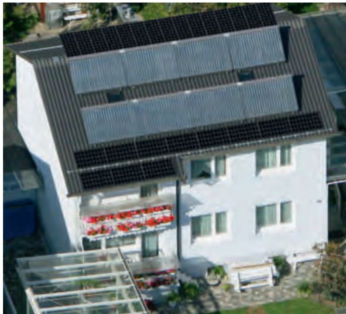
Das „Ökohaushaus“ verfügt seit Oktober 2009 über eine Photovoltaik-Anlage, die zusätzlich zur Solarthermie nachhaltig für Energie sorgt.
